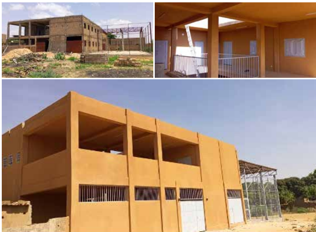
L'école et centre de formation professionnelle en cours de construction.
