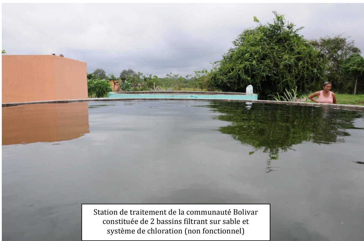
Station de traitement de la communauté Bolivar constituée de 2 bassins filtrant sur sable et système de chloration (non fonctionnel)
